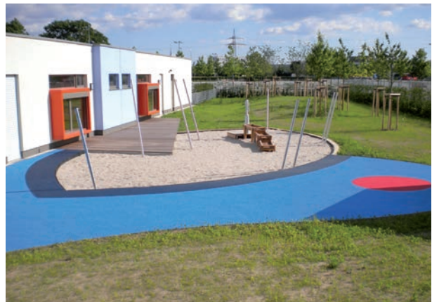
playfix® EPDM IS in einer Kindertagesstätte in Mannheim: Die eigentliche Fallschutzfläche besteht aus Sand, playfix® EPDM IS bildet den dekorativen Rahmen.
