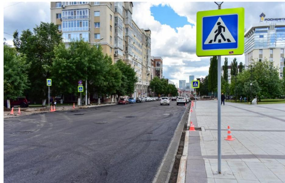
Разрыв между проезжей частью и тротуаром во время проведения ремонтных работ. Через такую щель человек на инвалидном кресле не сможет самостоятельно проехать. Есть риск спотыкания и падения всех горожан без исключения.
